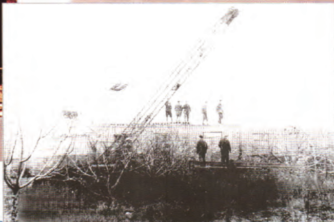
● Продовжувалось будівництво нового навчального корпусу. Швидко були укладені бетонні перекриття.
