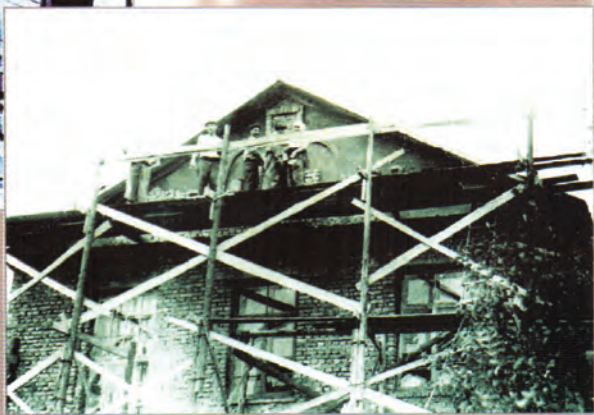
● Виконання зовнішніх робіт.
