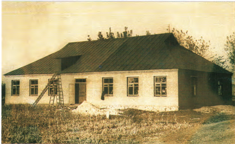
● В 1968 році завершилося будівництво шкільної майстерні.
